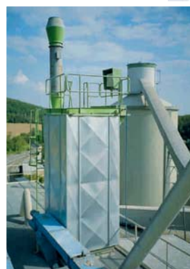
filtr na zásobník s regenerací puls-jet včetně odsávacího ventilátoru
