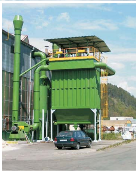
filtry HFH off-line - kovářské - tavící pece Al - filtrační výkon celkem 48 000m 3 /h
